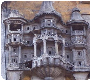
Kuş evlerinin yapılması
