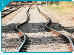
Yazın tren raylarının genişmesi
